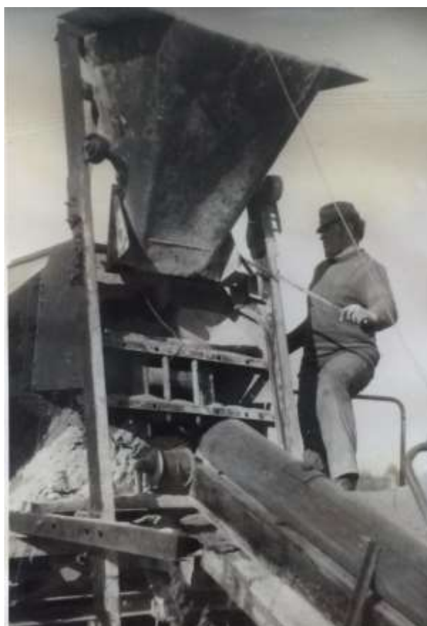
Seriál snímků z opravy podlahy v celé budově střelnice....
