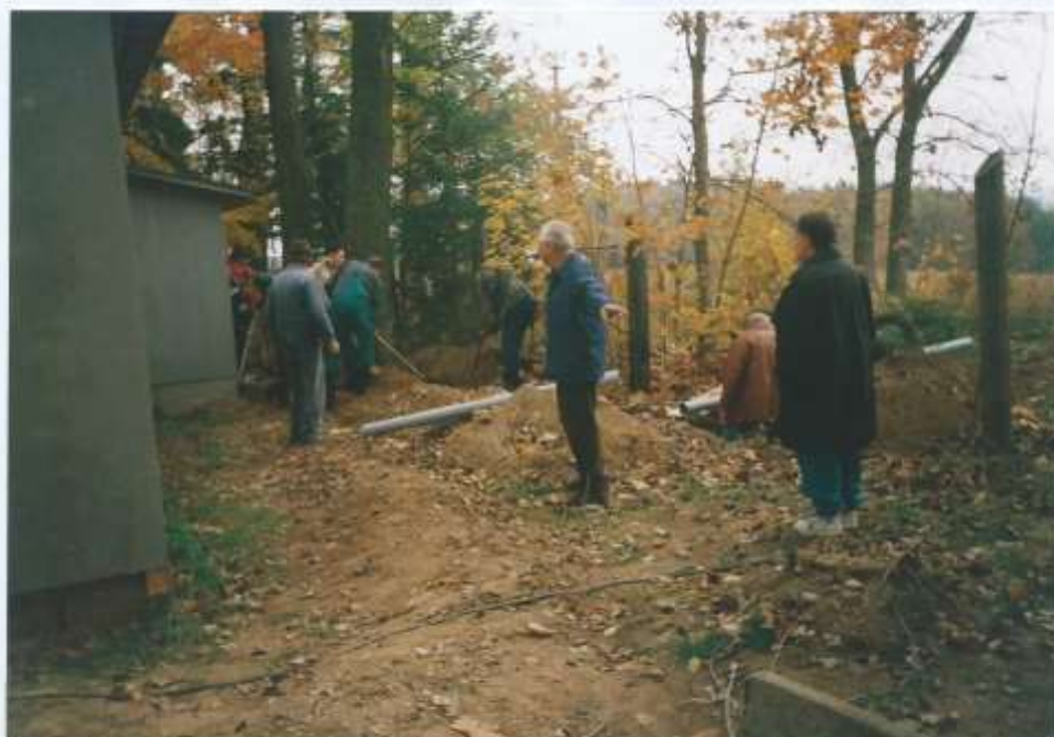
Při poslední brigádě v roce 1999 se pokládalo odpadní potrubí...
