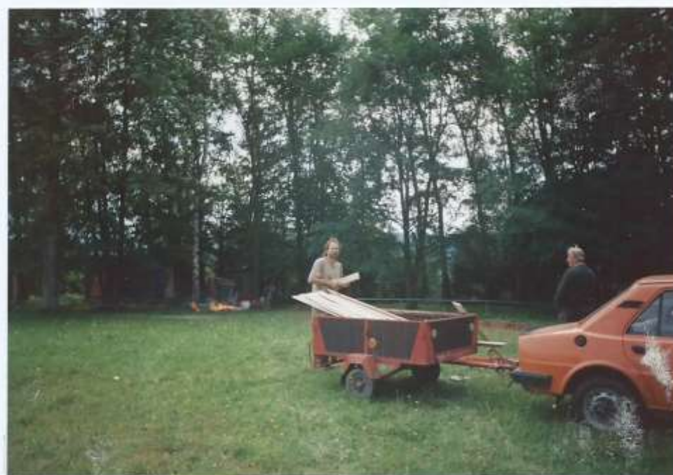
Práce na zastřešení a opravě zakoupené chatky.
